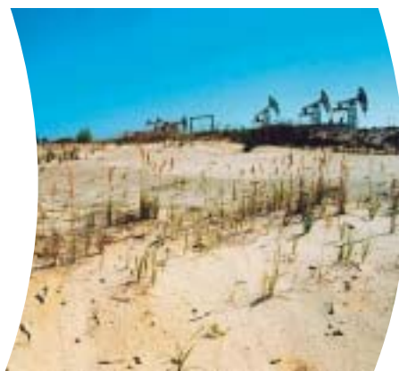
Шламовый амбар, засыпанный привозным песком 12 лет назад
